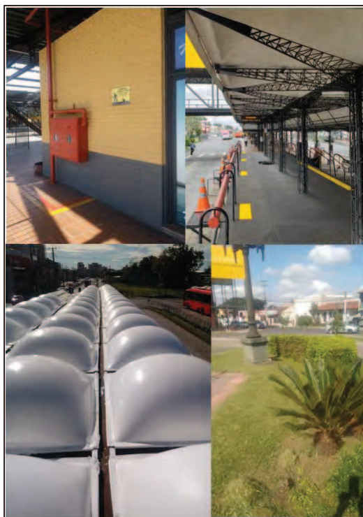
Imagem 6: MANUTENÇÃO DOS TERMINAIS
